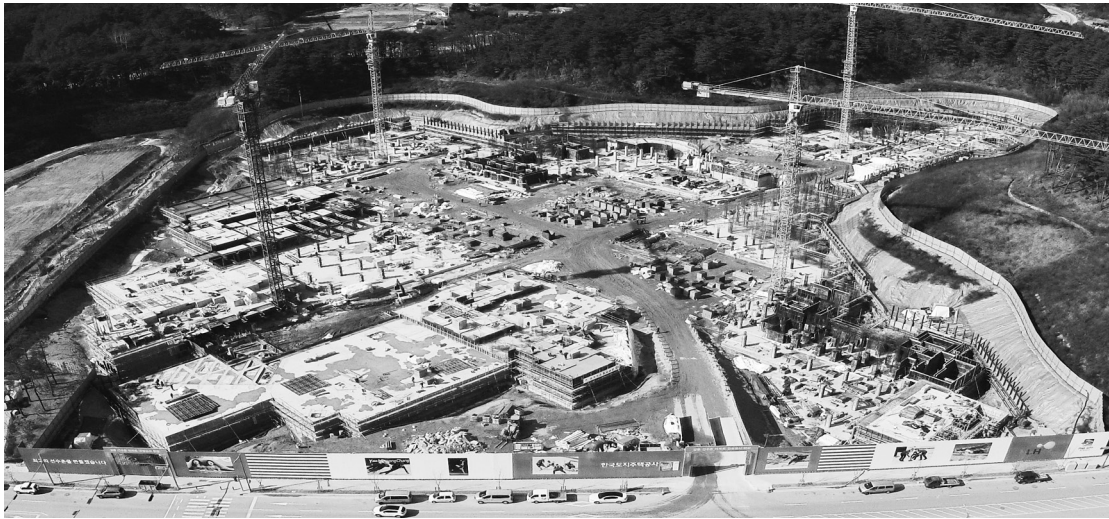
2017년 9월 완공을 목표로 건설 중인 평창동계올림픽 선수촌.
